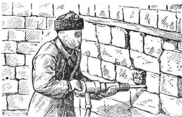
Рис. 36. Пробивание отверстия в стене убежища
